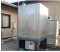
特定施設水道連結型スプリンクラーポンプユニット
