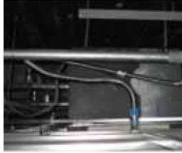
天井裏配管工事
